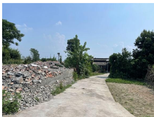
东北侧顺江村拆迁现状
