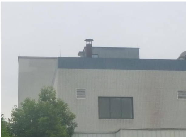
锅炉废气排气筒
