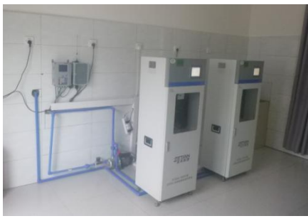
污水处理站出水在线监测（COD、氨氮）
