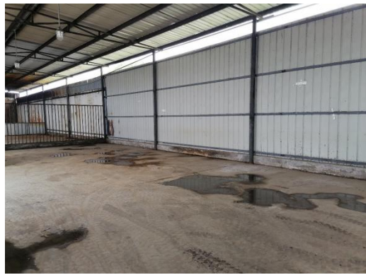
一般固体废物存放间
