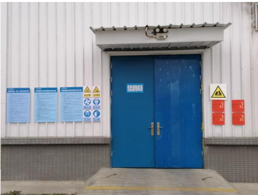
危险废物贮存间
